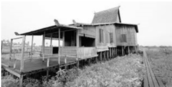
Gambar 19. Rumah Bubungan Tinggi Sumber : Analisis Penulis, 2019
