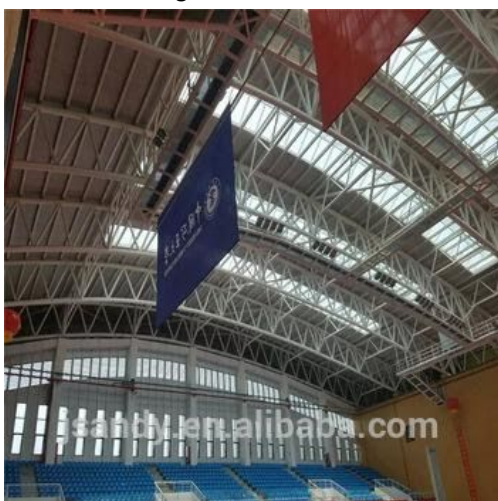
Gambar 17. Struktur atap space frame
