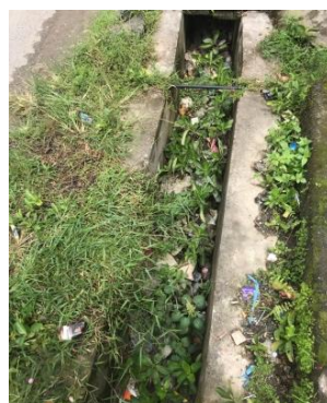
Gambar 3. 1 Kondisi Eksisting Saluran Drainase
