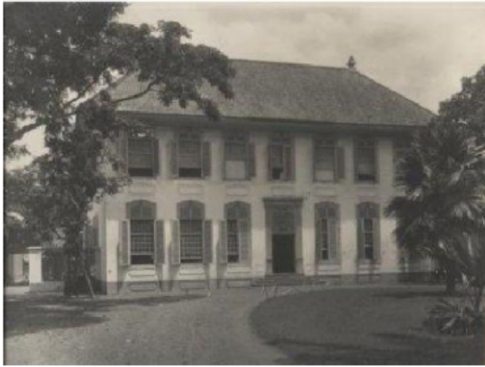
Gambar 4. Bangunan Kantor Pengelola Pertambangan Dienst van het Minjnwezen (Sumber : Buku De Oranje Nassau , 2018)
