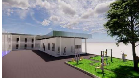
Gambar 19. Bangunan Angkat Beban/GYM
