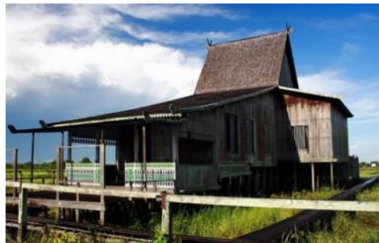
Gambar 4. Rumah Bubungan Tinggi sebagai salah satu bangunan yang menggunakan konstruksi panggung di atas lahan basah. (Sumber : rumahnusa.blogspot.com)
