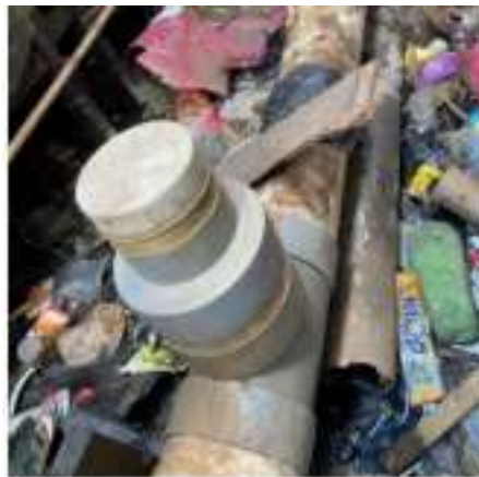
Gambar 3.3 Kondisi Outlet IPAL Komunal Kel. Tanjung Pagar RT.05
